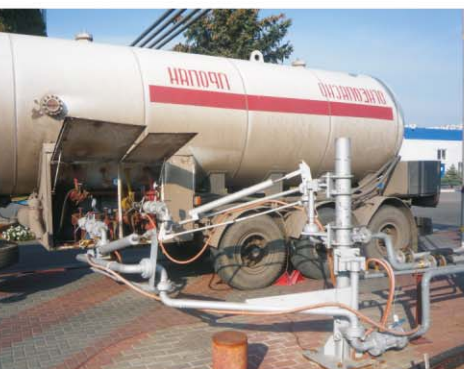
Технологическая система с применением газораздаточной колонки УИЖГЭ и вынесенным насосным блоком
