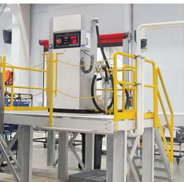
Кран раздаточный с автоматической отсечкой (собственного производства)
