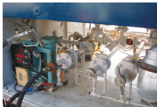
Технологическая система с применением газораздаточной колонки УИЖГЭ и вынесенным насосным блоком
